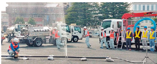
水道管に見立てた穴の復旧作業にとりかかる組合員
