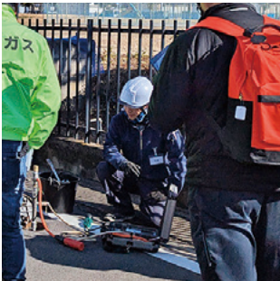
埋設管の気密試験
