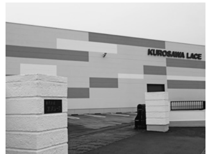
本社敷地内に移転した第2工場
