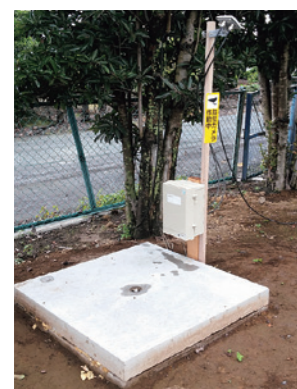
今回の補助金を活用したコンクリート二次製品施工の様子
