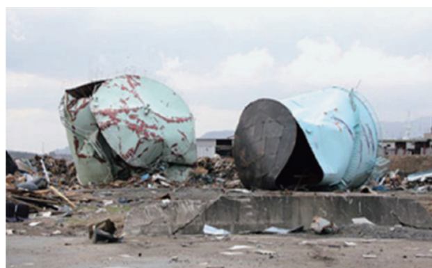
東日本大震災時のタンク転倒・崩壊の様子
