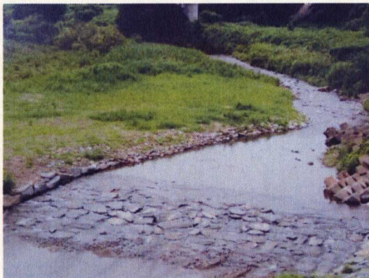
(一級河川鮎川 藤岡市白石地内)
