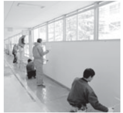
壁の塗装の様子
